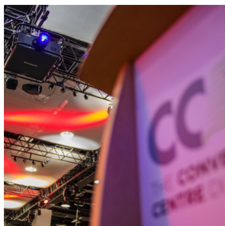
Podwieszany pod sufitem projektor w CCD
