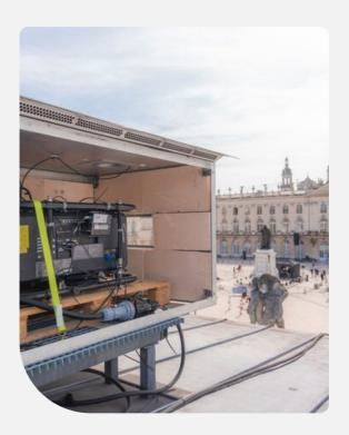
Todos los proyectores están conectados por fibra óptica a los servidores situados en el sótano del ayuntamiento. La instalación de cables también es discreta y está enterrada bajo los adoquines de la plaza.
