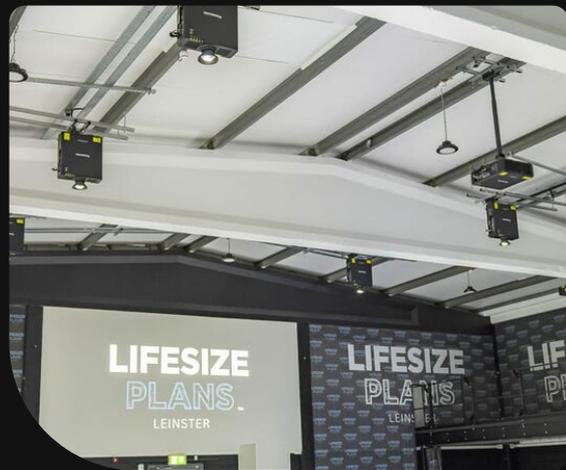
Die PT-RZ990-Projektoren von Panasonic bieten 20.000 Stunden wartungsfreien Betrieb mit dauerhafter Helligkeit und Farbgleichmäßigkeit. Die Projektoren der PT-RZ990-Serie verfügen über eine hermetisch abgedichtete optische Einheit und ein filterloses Kühl-Design auf Wärmepumpenbasis. Dies hält die Projektoren auf der optimalen Temperatur und verhindert das Eindringen von Staub, insbesondere wenn Objekte auf dem Boden des Ausstellungsraums positioniert werden, um die Projektion zu begleiten.
